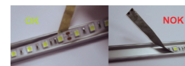
Image 3. Placement de bande LED en retirant la protection de l'adhésif au fur et à mesure de la progression
