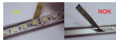
Image 3. Placement de bande LED en retirant la protection de l'adhésif au fur et à mesure de la progression
