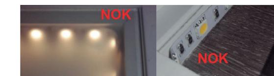
Image 9. Exemple NOK de réalisation de placement des bandes LED sur des montants d'angles, tournants ou changements de direction
