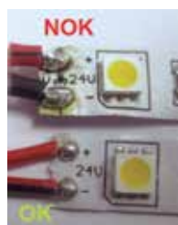
Imagen 6. Aspecto de soldadura OK y NOK
