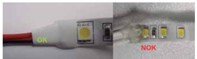
Imagen 8. Protección de unión cable-tira LED mediante termo-retráctil
